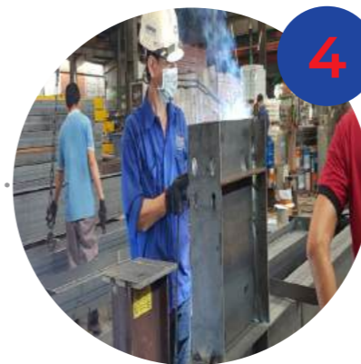
4 LẮP HOÀN THIỆN Finishing fit up
