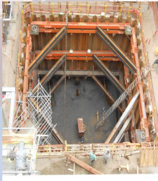
HỆ GIÀN CHỐNG SHORING SYSTEM
