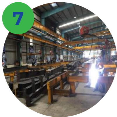
7 HÀN HOÀN THIỆN Finishing welding
