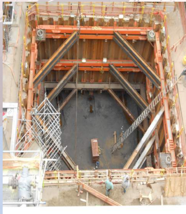
HỆ GIẰNG CHỐNG SHORING SYSTEM
