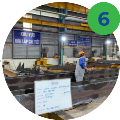
6 LẮP HOÀN THIỆN Finishing fit up
