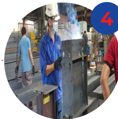
4 LẮP HOÀN THIỆN Finishing fit up
